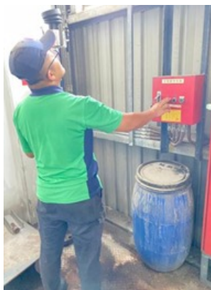
消防排煙檢測
