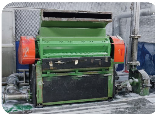
粉碎機黏貼包覆吸音棉降低噪音
